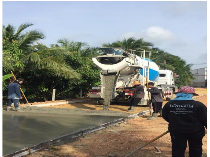
ก่อสร้างถนน คสล. สายละเียด ธาราชมพู หมู่ที่ 1
