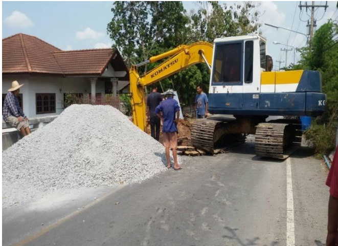
ปรับปรุงซ่อมแซมคอสะพาน หมู่ที่ 3
