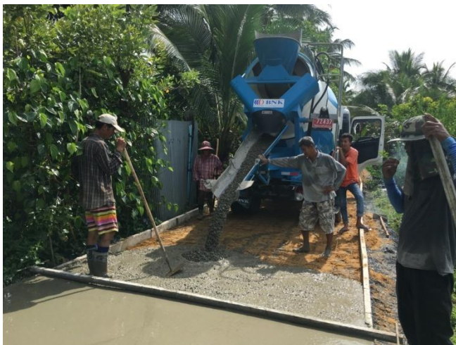
ก่อสร้างถนน คสล. สายบ้านลุงเซียง หมู่ที่ 5
