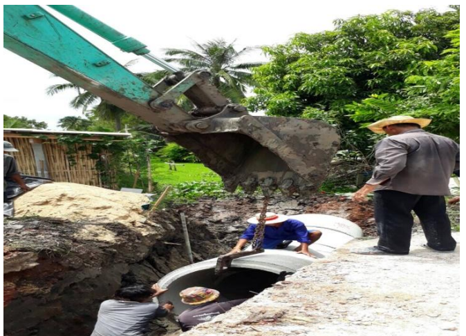
ก่อสร้างฝังก่อระบายน้ำ คสล.ตลอดใต้ถนน หมู่ที่ 5
