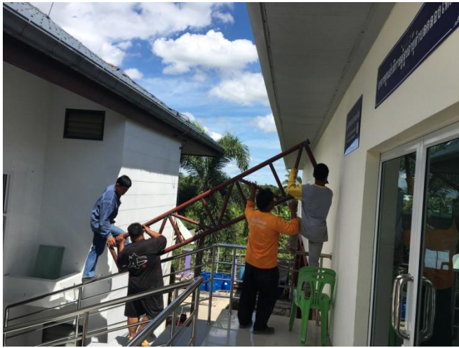
ติดตั้งหลังคา กันสาด พร้อมติดตั้งประตูกระจกอลูมิเนียม ที่ทำการ อบต.คลองใหม่
