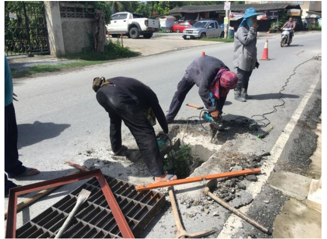
ปรับปรุงซ่อมแซมฝาท่อระบายน้ำ คสล. หมู่ที่ 3
