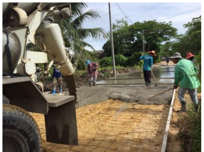
ก่อสร้างถนน คสล.พร้อมฝังท่อระบายน้ำ คสล. ซอยทรัพย์สมบูรณ์ หมู่ที่ 2
