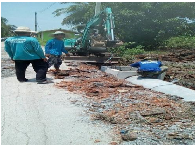
ก่อสร้างถนน คสล.พร้อมฝังท่อระบายน้ำ คสล. ซอยทรัพย์สมบูรณ์ หมู่ที่ 2
