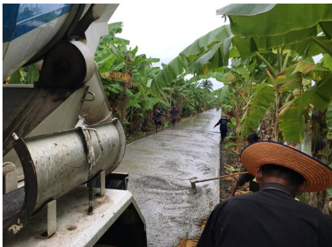
ก่อสร้างถนน คสล. สายบ้านทองชัน สวัสดิแพทย์ หมู่ 5
