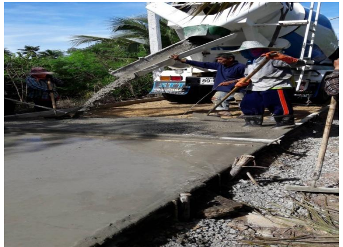
ก่อสร้างถนน คสล. นายสังวาล ภิรมย์นา หมู่ที่ 5
