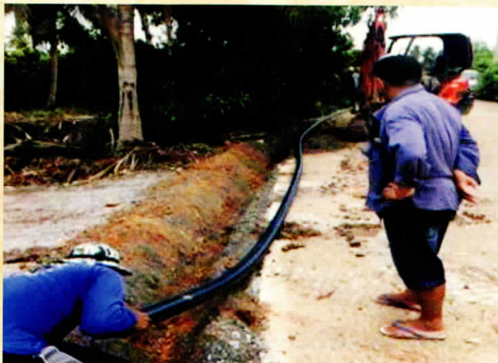
โครงการจ้างเหมาเปลี่ยนท่อเมนประปา HDPE หมู่ที่ 1 - หมู่ที่ 6
