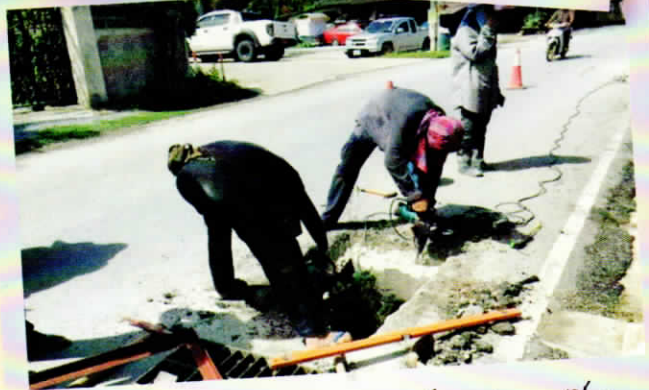
ปรับปรุงซ่อมแซมฝาท่อระบายน้ำ คสล. หมู่ที่ 3
