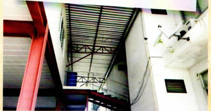
ติดตั้งหลังคา กันสาดพร้อมติดตั้งประตูกะจากอลูมิเนียม ที่ทำการ อบต.คลองใหม่
