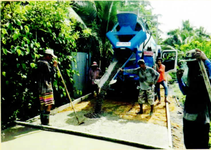
ก่อสร้างถนน คสล. สายบ้านลุงเขียง หมู่ที่ 5
