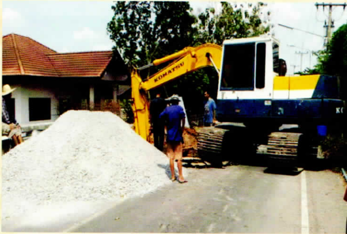
ปรับปรุงซ่อมแซมคอสะพาน หมู่ที่ 3
