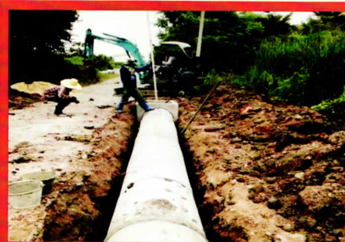
ก่อสร้างถนน คสล. สายบ้านทองขัน สวัสดิเทพย์ หมู่ 5
