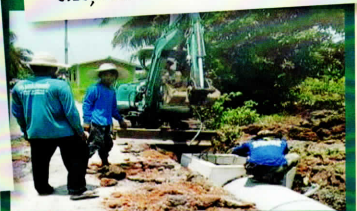
ก่อสร้างถนน คสล.พร้อมฝาท่อระบายน้ำ คสล. ซอยทรัพย์สมบูรณ์ หมู่ที่ 2
