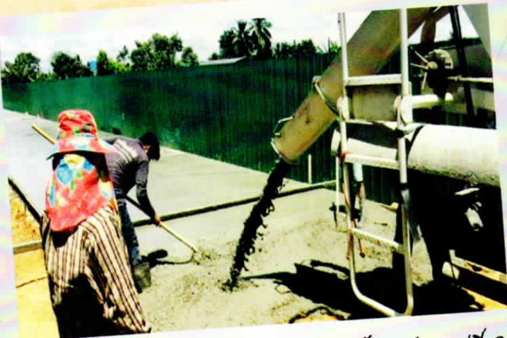
ก่อสร้างถนน คสล.พร้อมฝาท่อระบายน้ำ คสล. หมู่ที่ 3
