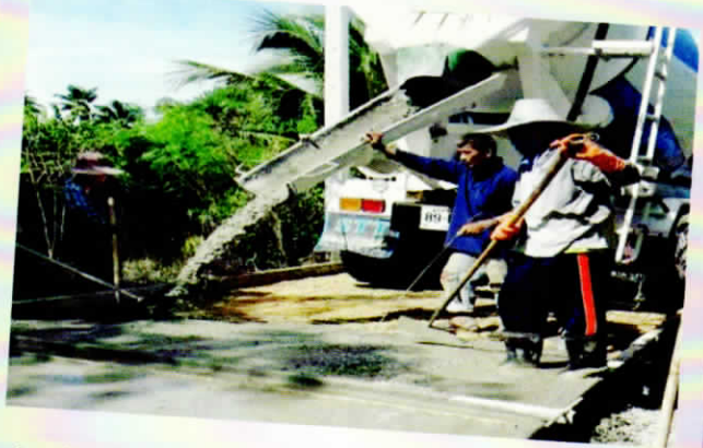
ก่อสร้างถนน คสล. สายนาขมพู ภิรมย์นา หมู่ที่ 5
