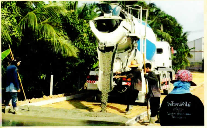
ก่อสร้างถนน คสล. สายละเอียด ธาราขมพู หมู่ที่ 1
